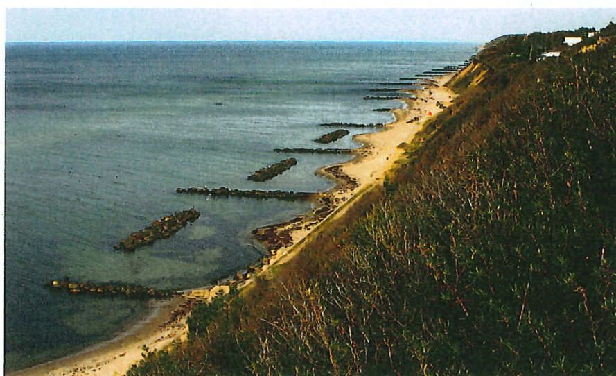
Fig. 5.47: For at begrænse erosionen af den jyske vestkyst er der opført hølde med mellemliggende bølgebrydere. Hølde virker ved at holde på det sand, der transporteres langs med stranden. Problemet med hølde er, at det sand, hølde holder på, mangler nedstrøms for hølde. Den gavnlige effekt af hølde ét sted resulterer i en negativ effekt nedstrøms for hølde, hvor man også må opføre hølde osv. (Foto: Scanpix/Henning Bagger).
