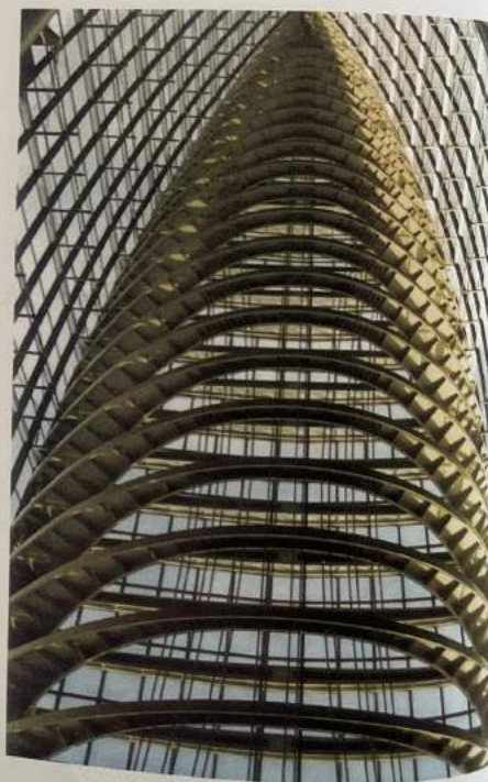
„International Forum“ i Tokyo. Den bærende konstruktion under taget er parabelformet både på langs og på tværs.
