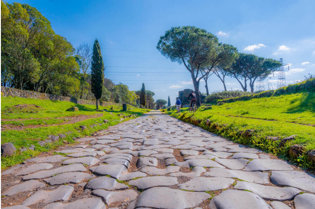
Intakt romersk vej syd for Rom. Læg mærke til de tydelige hjulspor i brolægningen.
