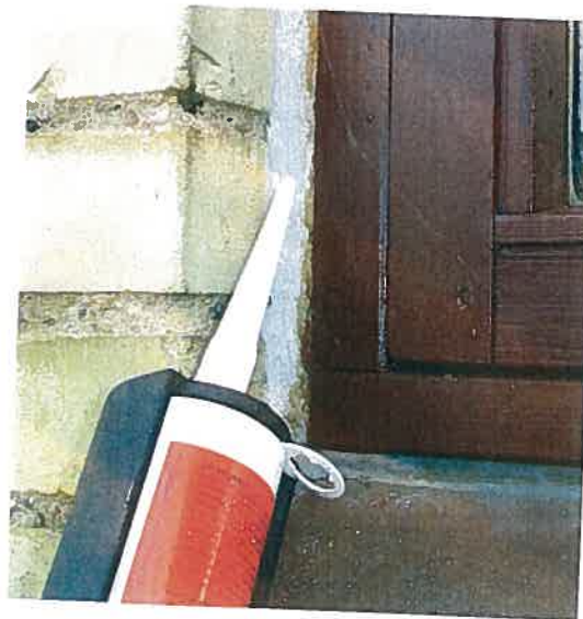
Figur 13. Fugemasse omkring vinduer i ældre huse indeholder ofte APE-stoffer.
