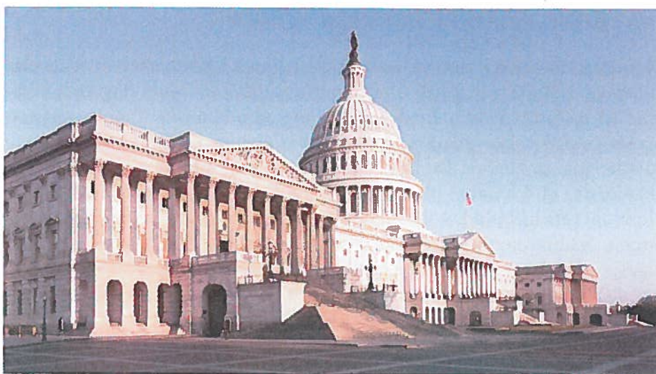
Capitol Hill, der huser den amerikanske kongres med Senatet og Repræsentanternes Hus, er bygget med inspiration fra tempelbyggerier fra de gamle græske og romerske demokratier, der blev brugt som forbilleder for moderne demokrati.
