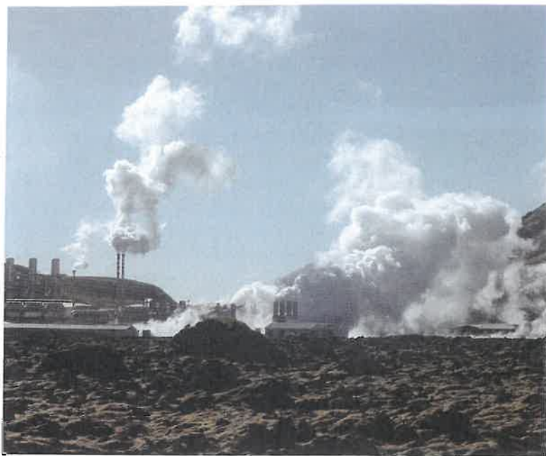
9.31 Det geotermiske kraftværk i Nesjavellir i Island
