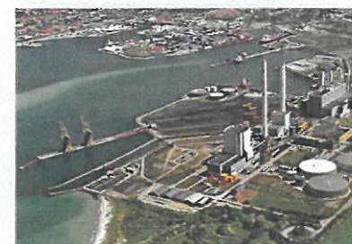
FIGUR 2.40 ▼ Asnæsværket i Kalundborg har i mange år været Danmarks største kraftværk med en effekt på lige godt 1 GW. Værket er dog ved at blive lukket ned for kuldrift på grund af faldende elforbrug. I stedet skal det køre med en mindre ydelse ved afbrænding af træflis, hvilket belaster miljøet mindre end afbrænding af kul.
