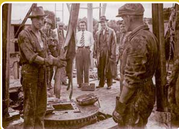
Den første dybe boring i dansk undergrund ved Harte i Jylland i 1935, som nåede næsten en kilometer ned, dog med nogle problemer undervejs – som her, hvor røret er knækket. Dapco-ejer Fred Rawlin står som nr. to fra venstre.
