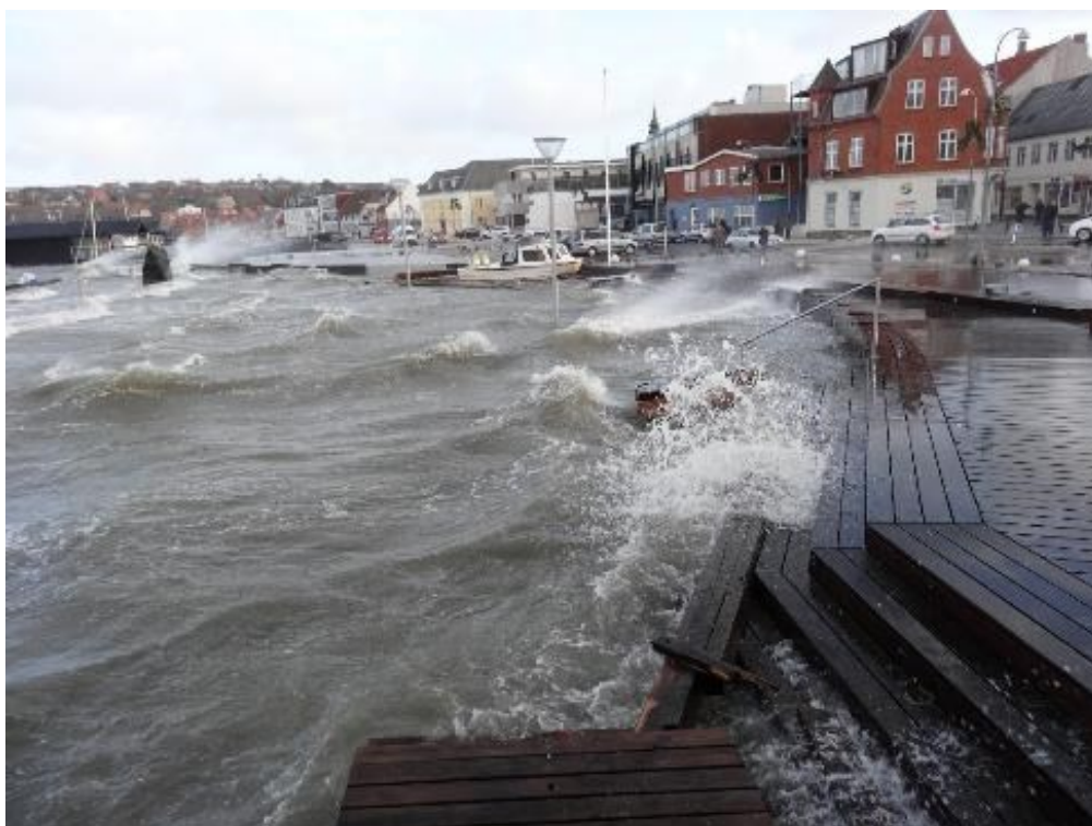
FIGUR 13 HØJVANDSMUR BESKYTTER LEMVIG UNDER STORMFLOD. KILDE: KYSTDIREKTORATET.
