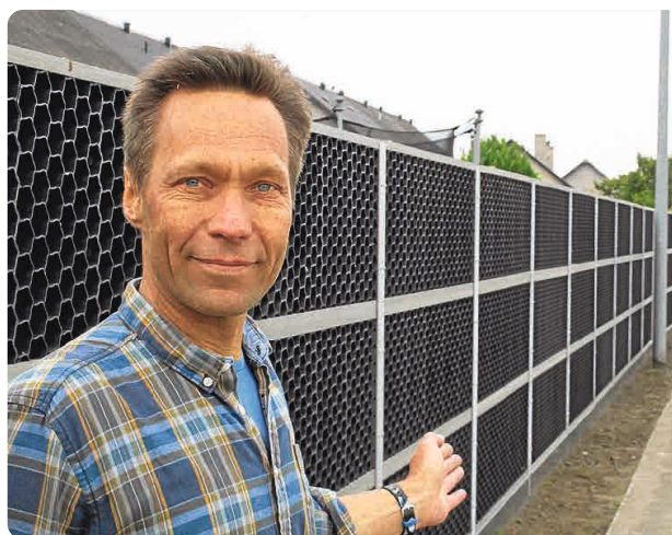
Indehaver af Miljøskærm, Jakob W. Nielsen, har tidligere lavet en små 100 meter lang støjskærm i Vallensbæk af glasfiber fra vindmøller. (Foto: Miljøskærm)
