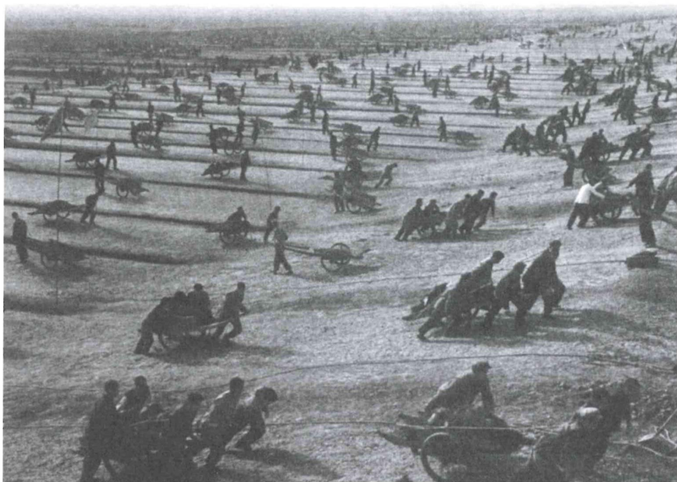
Bygning af vandreservoir ved floden Huai. Udnyttelsen af den menneskelige arbejdskraft antog enorme dimensioner under Det Store Spring Fremad.
