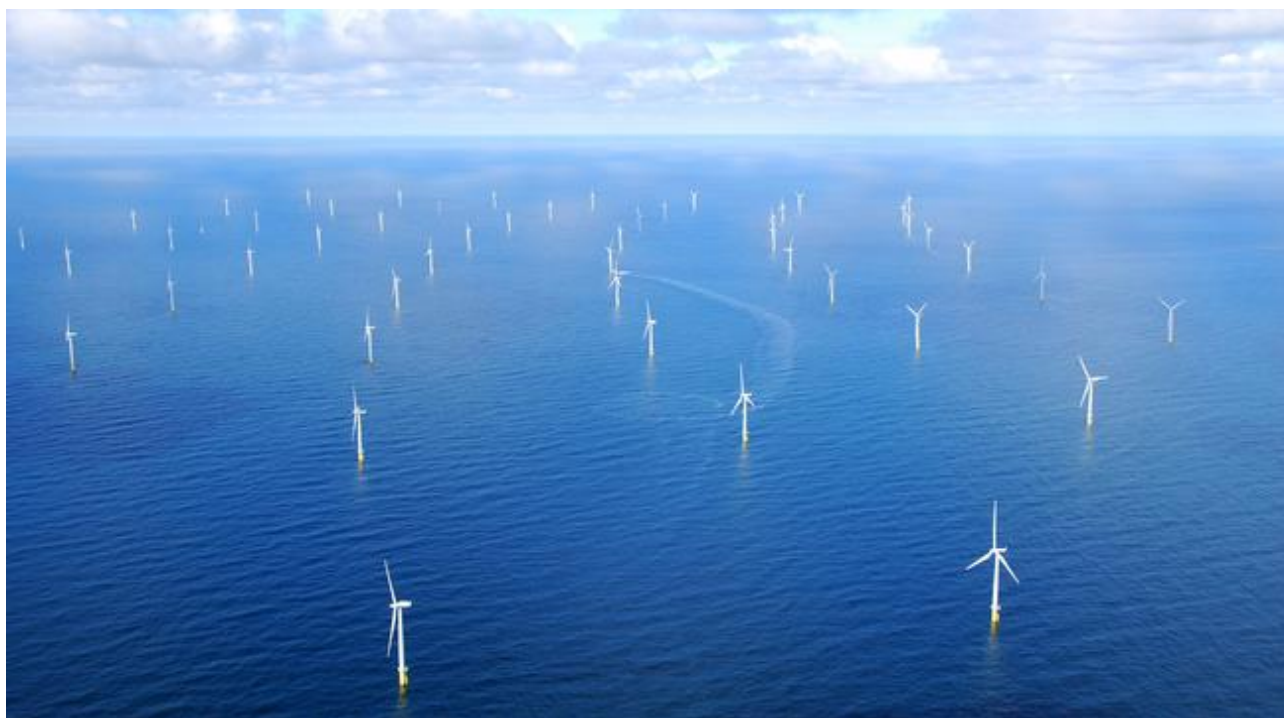
Figur 2.4.4: Havvindmølleparken Horns Rev 2 nær Esbjerg. Energinet, Foto: Danish AirPhoto
